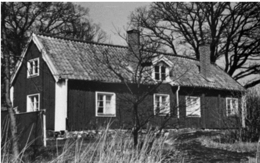
Figur 16: Sjökragens byggnad (Digitalt museum).
