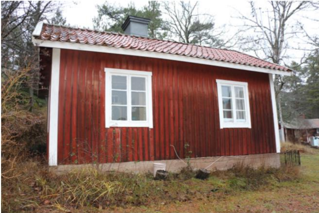
Figur 29: Stuga på Fagerdala 1:3>1 (Tengbom).
