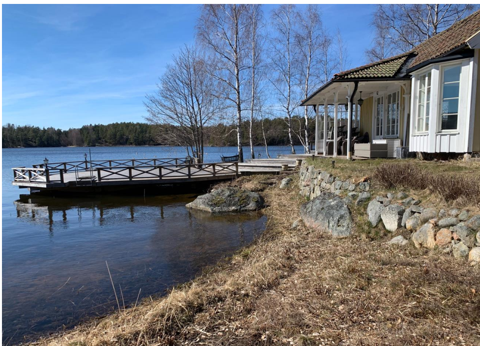
Figur 11: Säby 1:55, Berg eller stora block mellan befintlig byggnad och Återvallsträsket.
